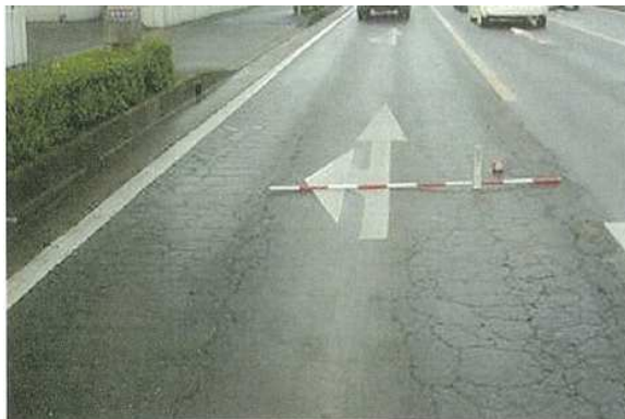
写真1 アスファルト舗装の現況
